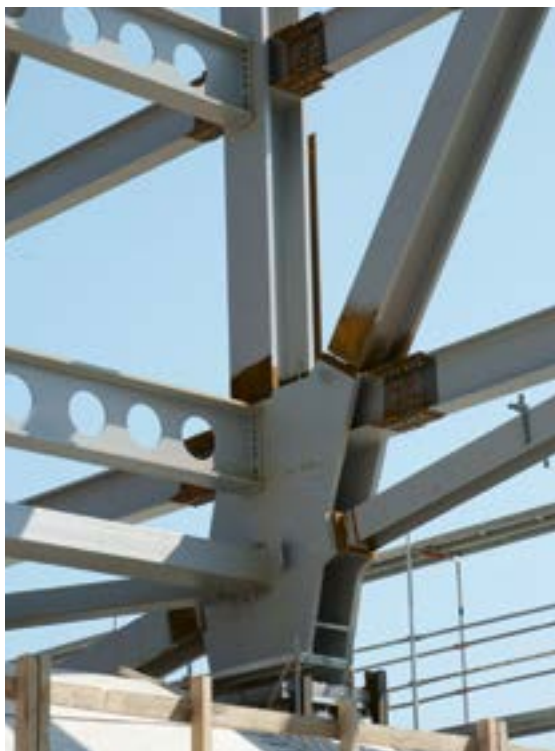
Verbindung eines Knotens vor dem Verschweissen der Diagonalstäbe und der Querträger.
