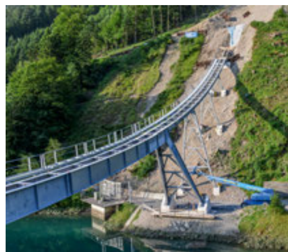
Baufortschritt der Brücke der Talstation (von links nach rechts).
