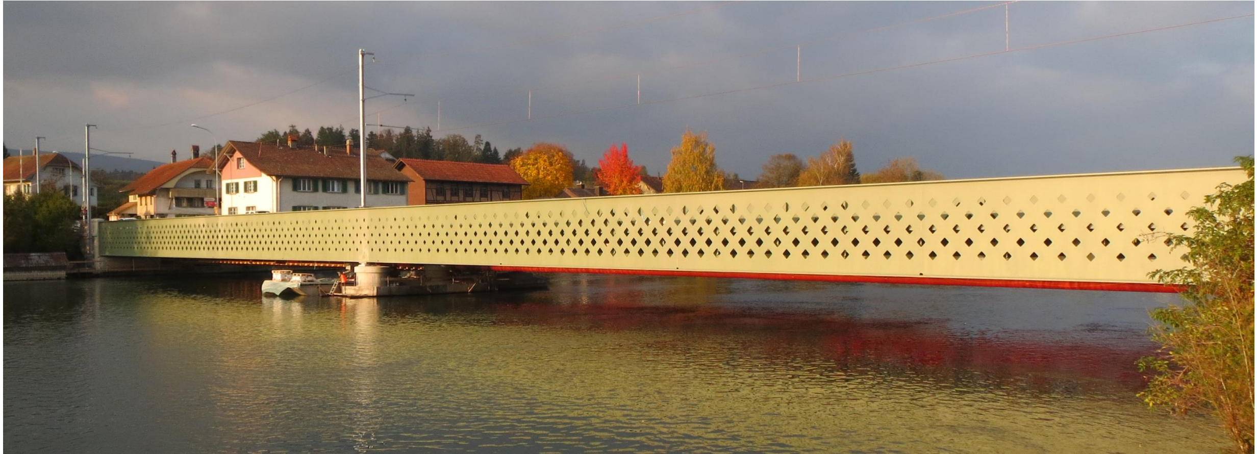
Neue Bahnbrücke bei Aarwangen (BE), 2015
