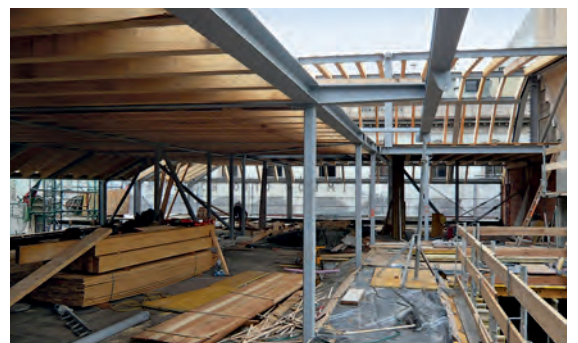
Die ein- bis zweigeschossige Aufstockung wurde als Stahl-Holz-Konstruktion ausgeführt.
