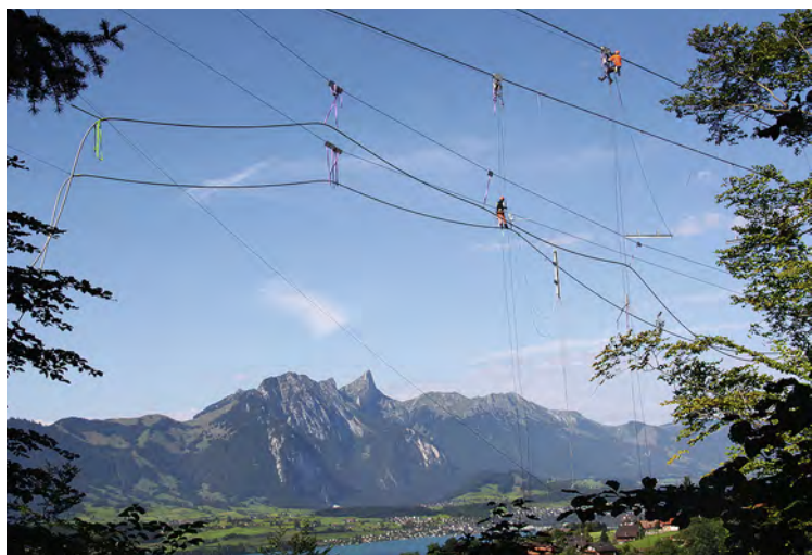
Einziehen der Seile in 180 Meter Höhe über dem festen Boden
