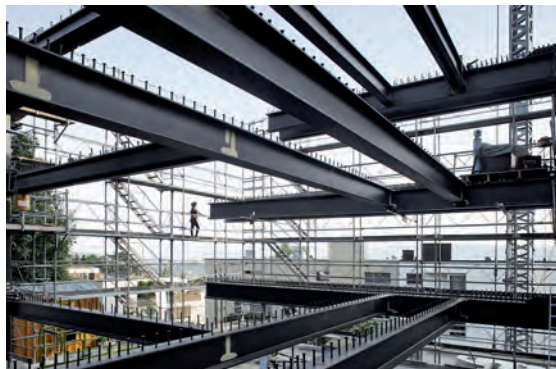
Montage der tragenden Stahlkonstruktion
