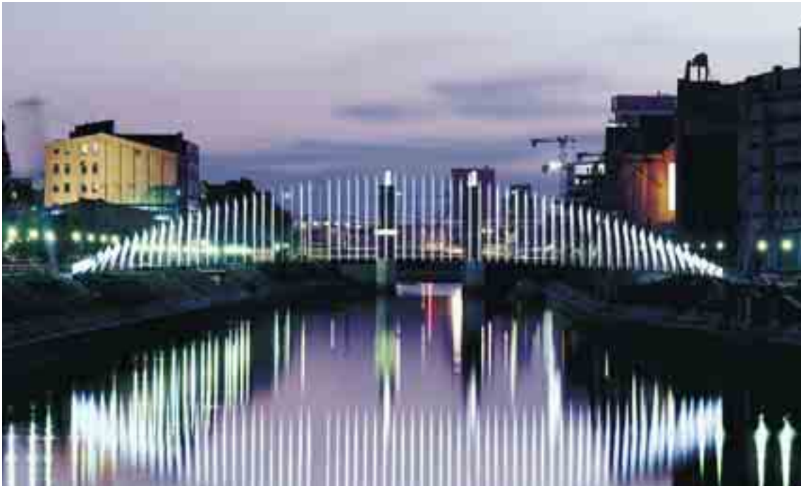
Nachts wird die Brücke von integrierten LED-Leisten beleuchtet.
