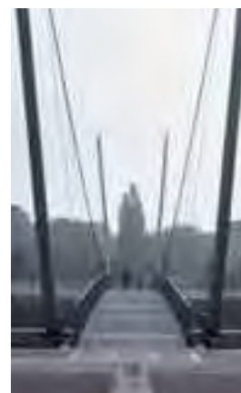
Werden die Mastspitzen nach aussen gekippt, hebt sich die Brücke in der Mitte um 10,60 m – im Normalzustand ist der «Buckel» 1,10 m hoch.
