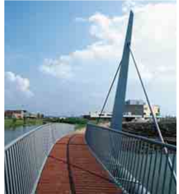
Die vom Pylon abgehängte Lauffläche folgt in einem leichten Bogen dem Fussweg.
