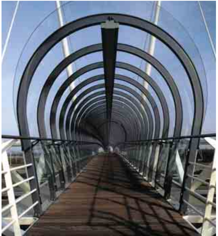
Geschützt vor der Witterung erreichen die Fussgänger die Raststätte.
