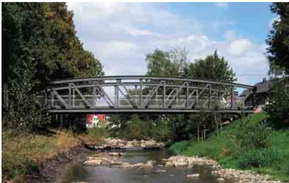
Die alte Strassenbrücke, vor über neunzig Jahren im Heiss-Niet-Verfahren hergestellt, wird heute an einem neuen Standort als Fussgängerbrücke genutzt.
