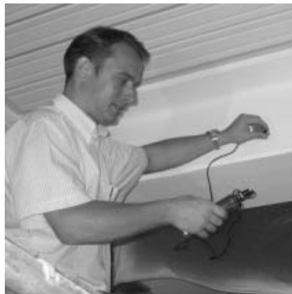
Qualitätssicherung: Schichtdicken-Messung vor dem Aufbringen der Deckbeschichtung
