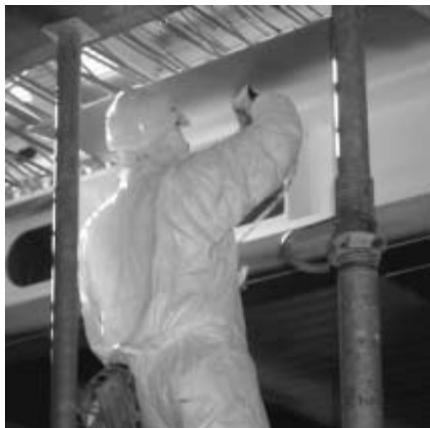
Applizieren des dämmschichtbildenden Brandschutzsystems
