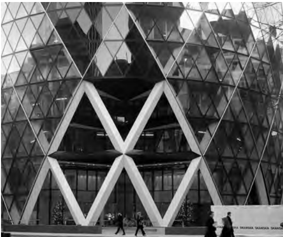
Swiss Re-Konzernzentrale, London (GB), 2004, von Foster & Partners: Andere Erdgeschossnutzung ohne Wechsel der Tragstruktur. Die diagonalen Druckstäbe sind weiss und die horizontalen Zugglieder schwarz gestrichen.
