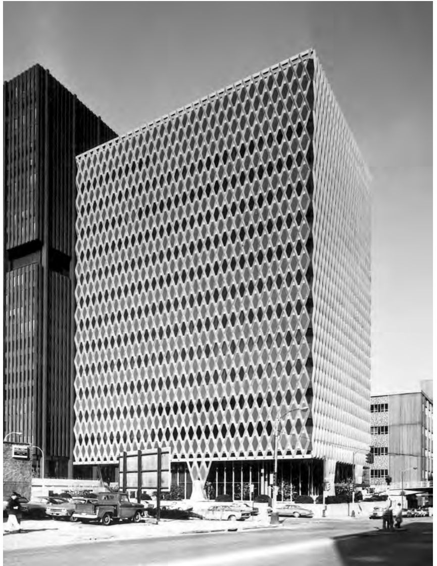
IBM-Building, Pittsburgh (USA), 1963, von Curtis & Davis Architekten: Eine der ersten Fassaden im mehrgeschossigen Hochbau ohne vertikale Stützen.
