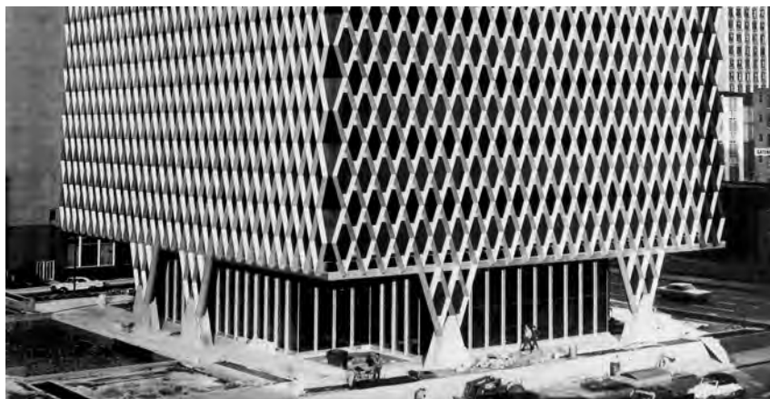
IBM-Building, Pittsburgh (USA), 1963, von Curtis & Davis Architekten: Kontinuierlicher Wechsel der Tragstruktur im Parterre – die Pylonen entstanden aus der Verlängerung einzelner Diagonalen.
