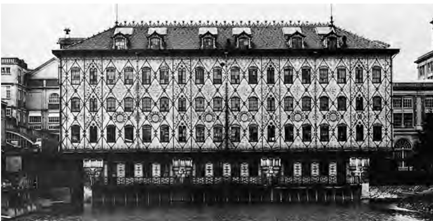
Schokoladenfabrik Menier, Noisiel-sur-Marne (F), 1873, von Jules Saulnier: Einzelne Fassadenstützen liegen hinter der Ausmauerung verborgen. Die Diagonalen sind nur aussteifend.
