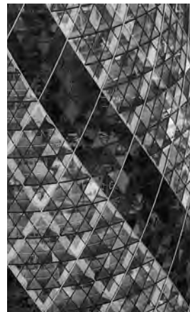
Konzernzentrale Swiss Re, London (GB), 2004, von Foster & Partners: Die Drehbewegung wird von den dunklen Gläsern der «Lightwells» vorgegeben.
