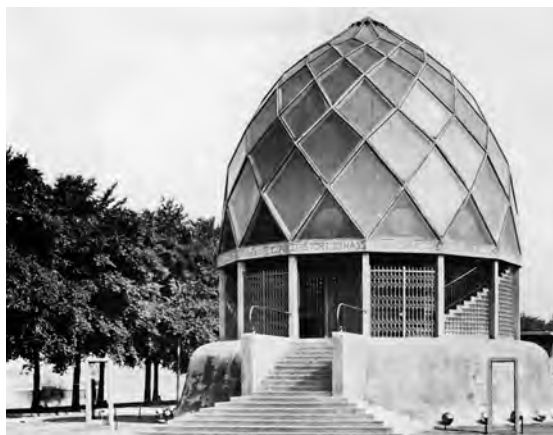
Glashaus an der Werkbund-Ausstellung in Köln (D), 1914, von Bruno Taut: Rechts- oder linksgerichtete Spiralen? Die Kuppel wurde als Eisenkonstruktion geplant, aber in Eisenbeton ausgeführt.
