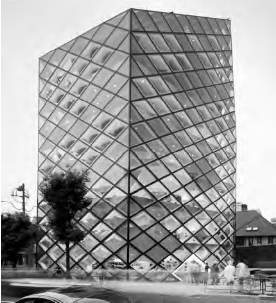
Prada Aoyama Epicenter, Tokio (JPN), 2003, von Herzog & de Meuron: Die Rauten bilden schiefe Bänder; auf der Zugangsseite folgt die Dachkante dem Band. Fast unbemerkt bleibt der Knick an der rechten Gebäude- kante.
