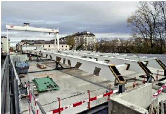
Zusammenbau der unteren Längs- und Querträger auf der Arbeitsplattform
