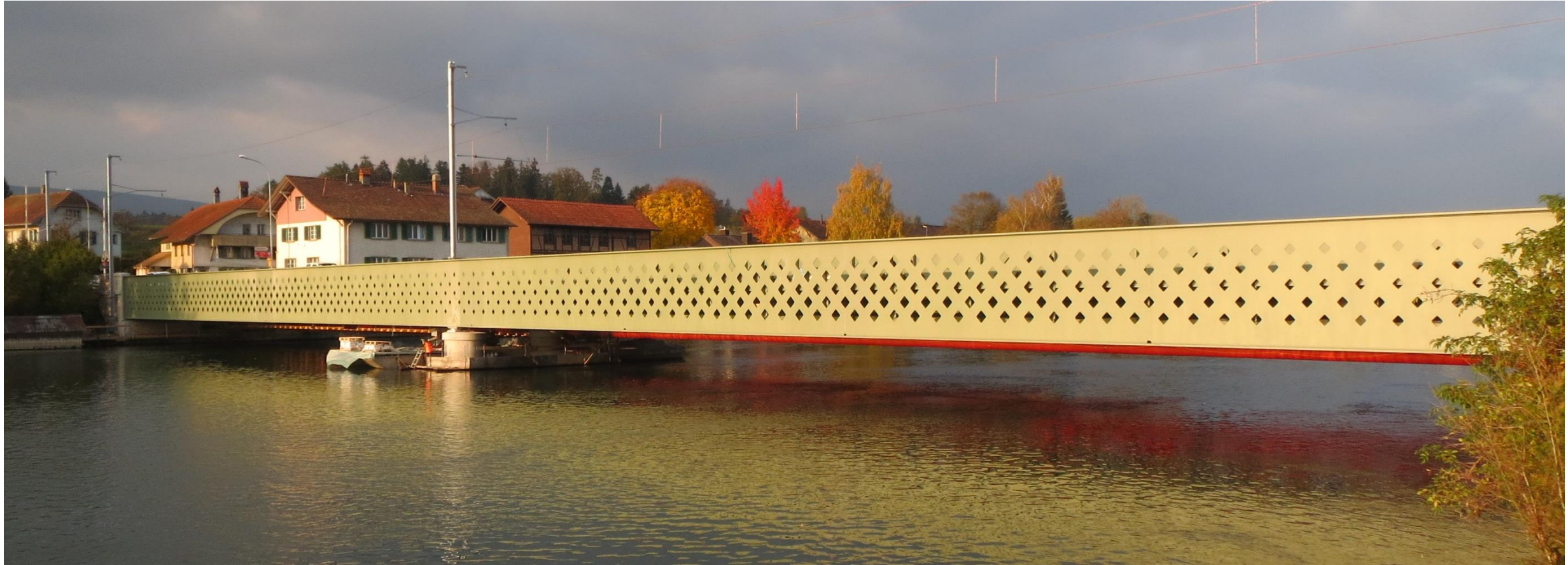
Neue Bahnbrücke bei Aarwangen (BE), 2015
