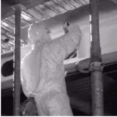
Abb. 5 Applizieren des dämmschichtbildenden Brandschutzsystems
