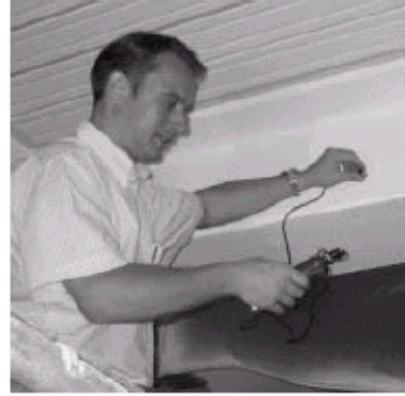
Abb. 6 Qualitätssicherung: Schichtdicken-Messung nach dem Aufbringen der Deckbeschichtung
