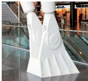
Stützenfuss, Flughafen Zürich, © R. Bensberg, Unique Appuis articulés, aéroport de Zurich, © R. Bensberg, Unique
