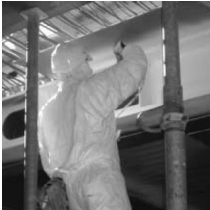
Applizieren des dämmschichtbildenden Brandschutzsystems
