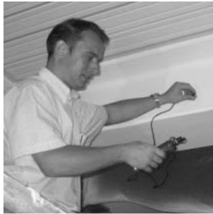
Qualitätssicherung: Schichtdicken-Messung vor dem Aufbringen der Deckbeschichtung
