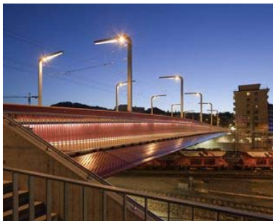
PRIX ACIER 2011 für die Langensandbrücke in Luzern – Bauherrschaft Stadt Luzern/Tiefbauamt und SBB AG – realisiert durch ein Schweizer Stahlbau-Unternehmen.
