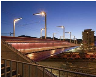
PRIX ACIER 2011 pour le Pont du Langensand à Lucerne – maître d'ouvrage : ville de Lucerne/office des ponts et chaussée et CFF SA – réalisé par une entreprise de construction métallique suisse.
